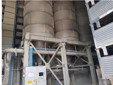
Figure 3 : Silos de stockage de poudre atomisé.
